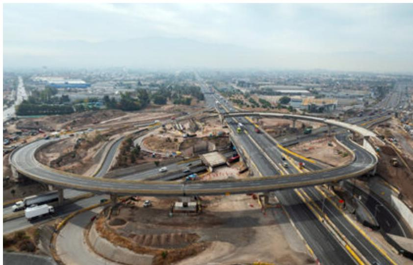
Este enlace, único en su tipo en Chile, reemplaza el antiguo trébol por un moderno diseño tipo “molino”, optimizando tiempos de viaje y seguridad vial entre la autopista Vespucio Norte y la Ruta 68.
