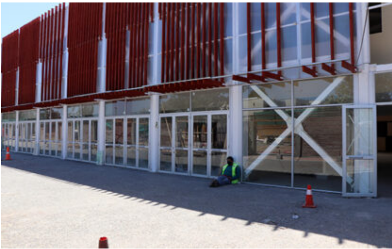
Acceso sur del nuevo Mercado Municipal
